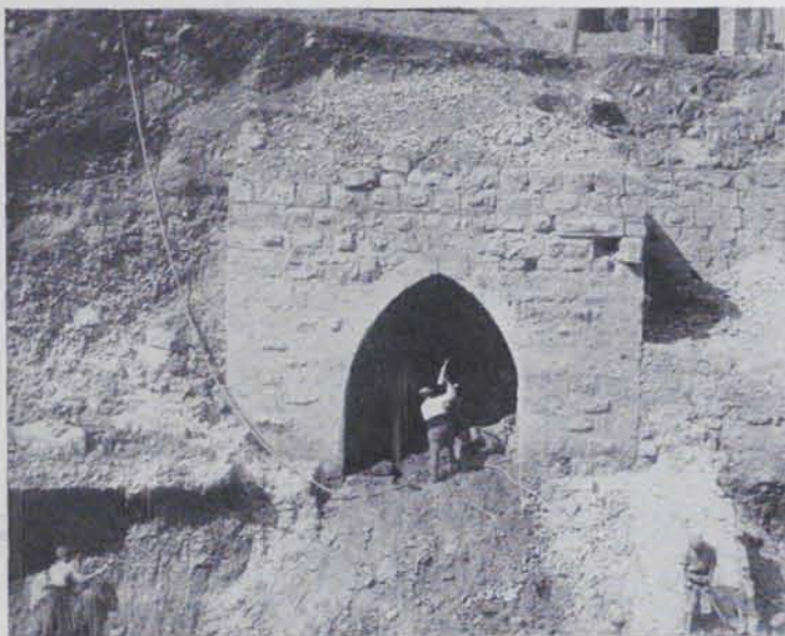
Fig. 282. — Montserrat : Portal de l'antic mur (Fot. Monestir de Montserrat)
